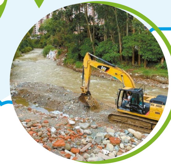
Obras de mitigación La Montañita Tablaza Inversión: más de 1.200 millones de pesos. Beneficiados: habitantes del sector La Montañita.
