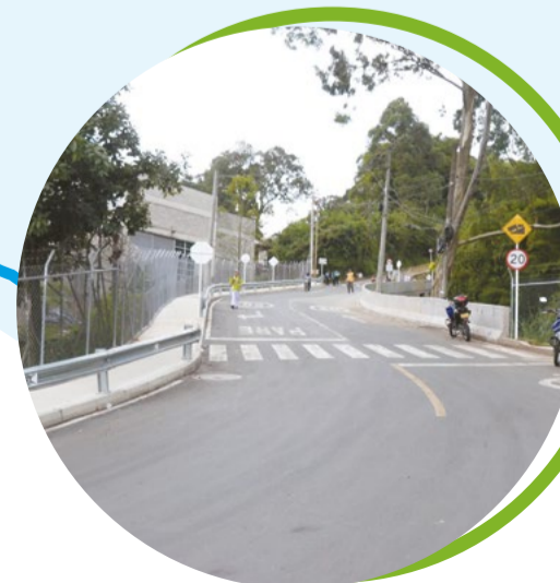
Ampliación calle 100 sur La Tablaza (Aledaño al proyecto Quality Center) Beneficiados: 76 mil personas.
