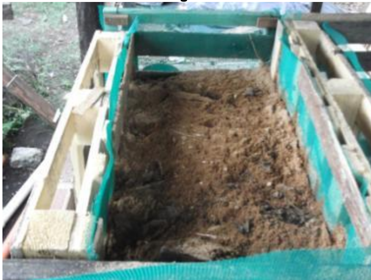
Imagen 23. Sistema instalado en el Asilo San Bernardo.
